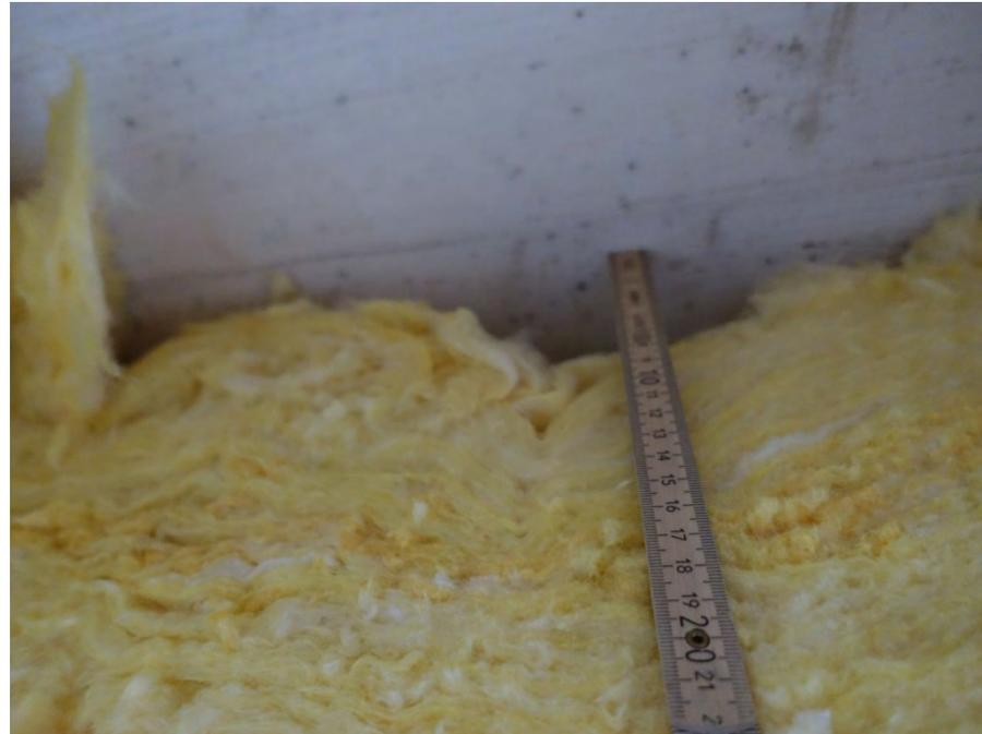
Und/oder gleichzeitig mit Konvektion in der Dämmebene zu rechnen ist: z.B durch Hohlräume
