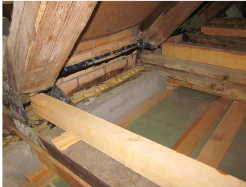
Bild: Bauschaden durch Konvektion
