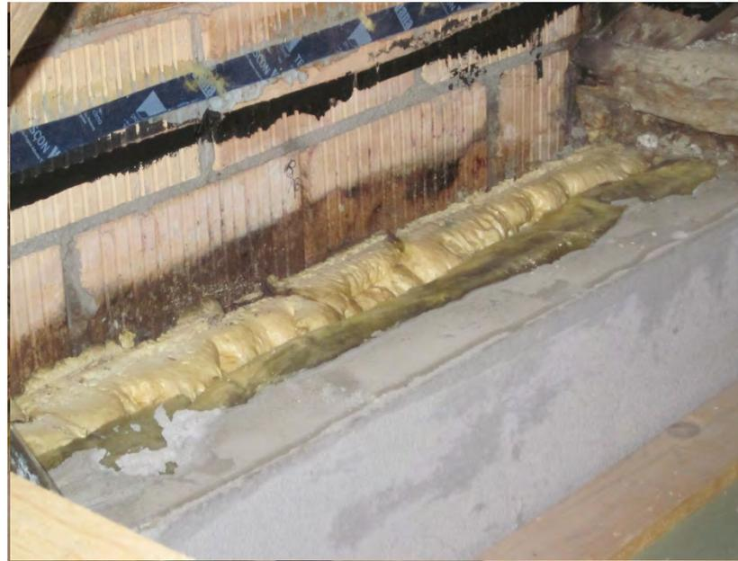
Bild: Bauschaden durch Konvektion
