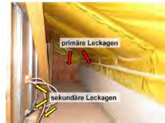
Abbildung 2: Beispiele für primäre Leckagen (unverputztes Mauerwerk, Fehlstelle in der Verklebung) und sekundäre Leckagen (Steckdose, Leerrohr, Holzkonstruktion/Rohboden) in einem Abseitenraum (planmäßig: Folie der Dachschräge und Putz als Luftdichtheitsschicht).
