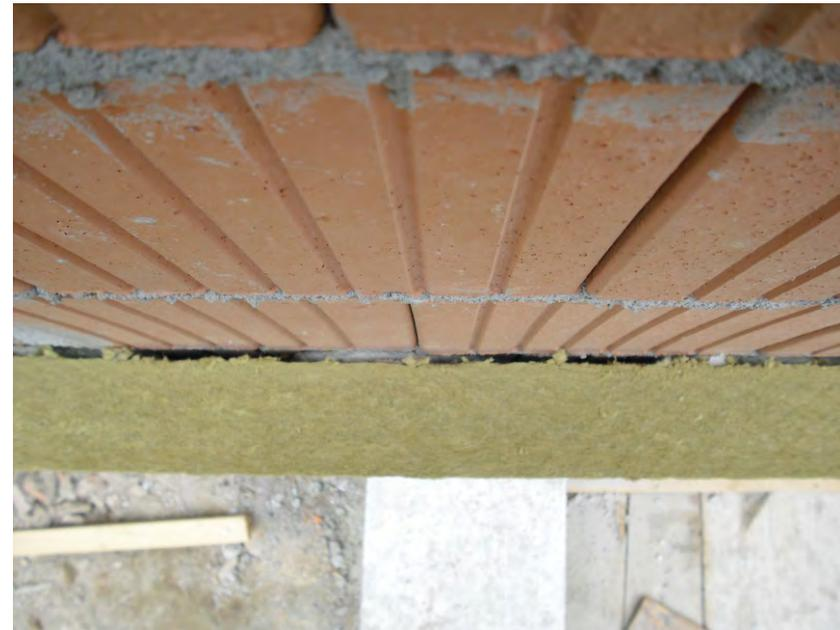
...Und/oder mit Konvektion in der Dämmebene
