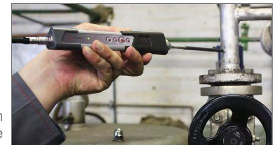
Überprüfen von Kondensatableitern mit Körperschallsonde
