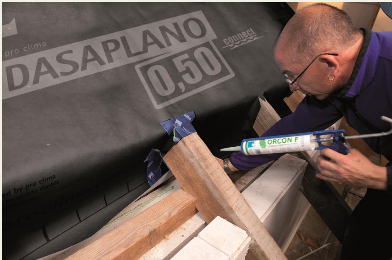
Die durchgängige Luftdichtung an der Traufe ist z.B. entscheidend für die Effizienz und Bauschadensfreiheit einer Dachsanierung von Aussen
