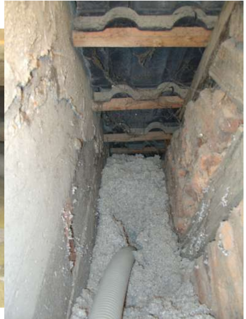
Ungewöhnlich: Gedämmter Ahlen
