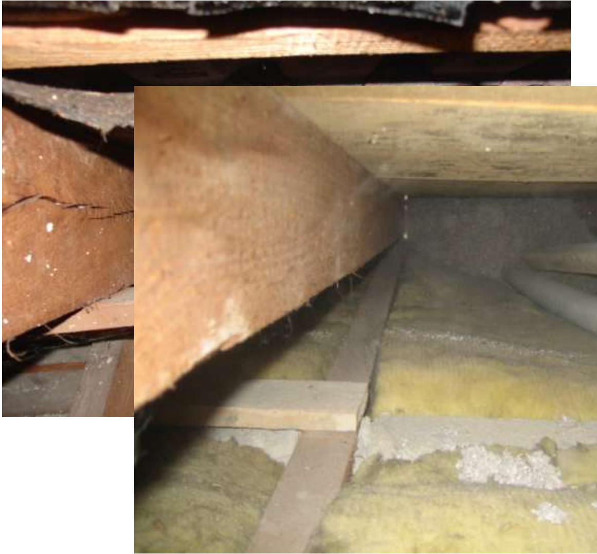
Ungedämmte Dachschräge ...keine Seltenheit
