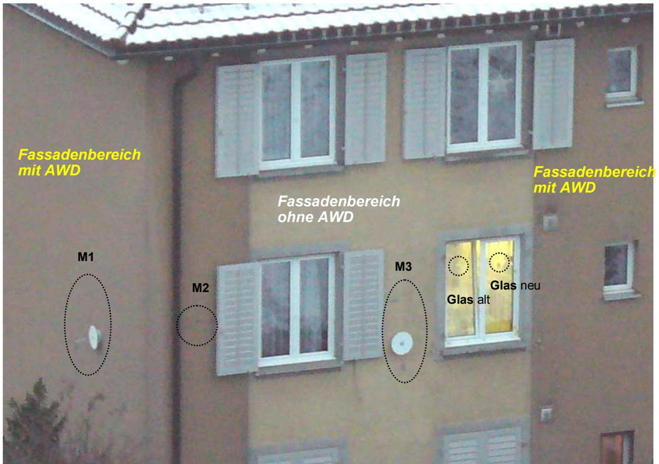
**Bild 6-4:** Aussenfassade analog Bild 6-1, mit Lage der Messstellen.
