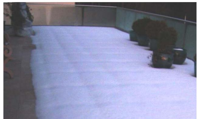
**Bild 8-9:** Ein Kontrast: Bei schneebedeckten Bauteilen sind keine energetischen Beurteilungen von IR-Bildern möglich, hier zeigt sich aber infolge einer Wärmebrücke ein „natürliches Wärmebild“.
