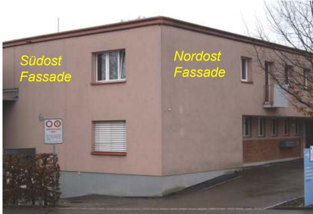
**Bild 4-9:** Gebäude mit verputzter AWD auf Empa Areal. Dämmung: ca. 12 cm EPS mit Dünnputz.
