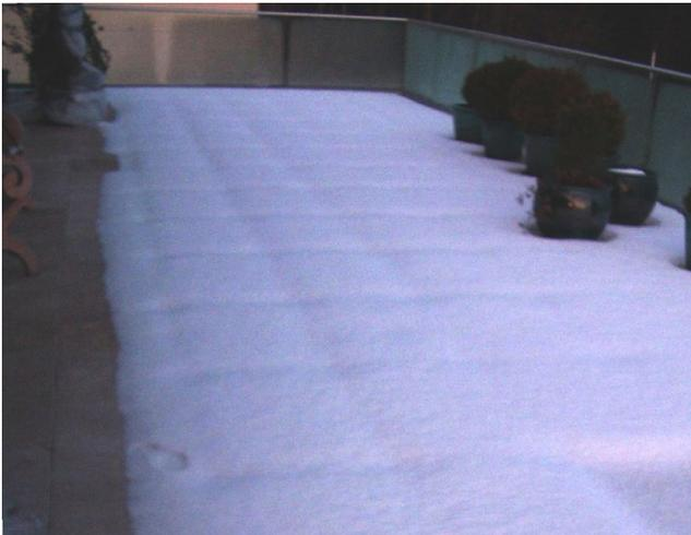
Das Beispiel links zeigt eine wärmegegedämmte Terrasse (darunter ist ein beheizter Wohnraum). Deutlich erkennbar sind hier auf der Schneefläche die Strukturen der Wärmedämmplatten, die bei den Plattenfugen offensichtlich eine starke Wärmebrückenwirkung haben.
