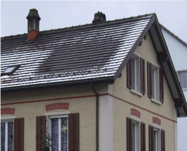
Bei frisch gefallenem Schnee kann auch ab und zu ein „**natürliches Wärmebild**“ beobachtet werden, weil je nach Abwärme des Untergrundes der Schnee auf dem Bauteil unterschiedlich schnell wegschmilzt.
