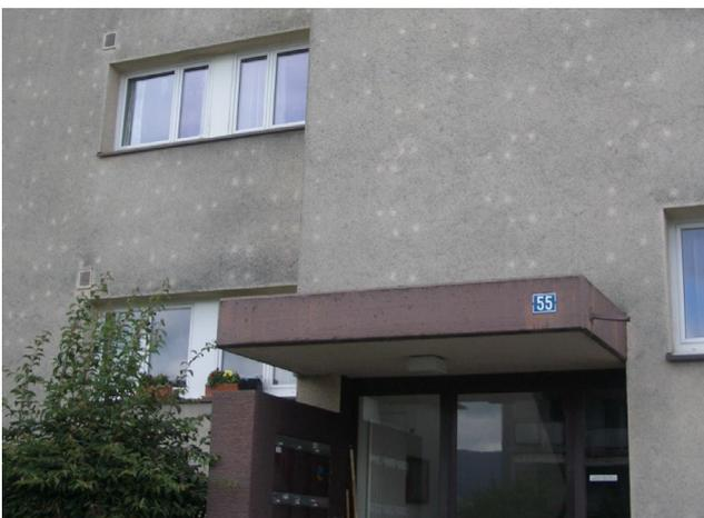
Blick auf eine Fassade mit verputzter Aussenwärmedämmung. Die Punktstruktur zeigt die Lage der Dämmstoffdübel, genau gleich wie die IR-Bilder im Kap. 7.5
