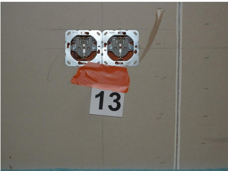
Abbildung 5: Steckdosen in einer Außenwand in Holzbauweise im 1. Obergeschoss. Der Volumenstrom durch die Leckage bei 50 Pa, ca. 1 m<sup>3</sup>/h, war den TeilnehmerInnen nicht bekannt – [8].
