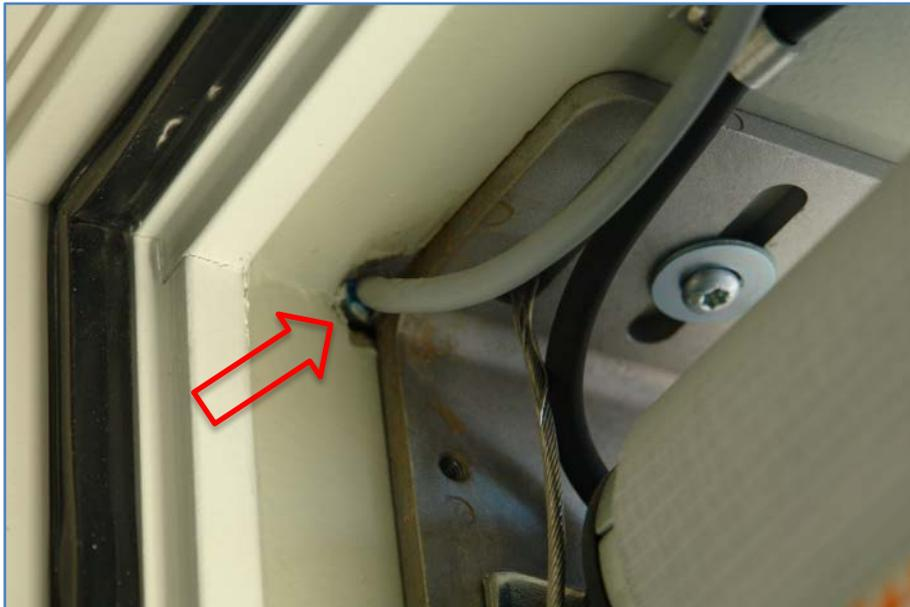
Offenes Elektro-Leerrohr, welches zu Kondenswasserbildung in der Fensterleibung sowie daraus resultierenden Schäden wie Farbabplatzungen und Korrosion geführt hat.
