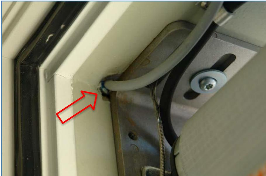
Gaine électrique ouverte ayant entraîné la formation d'eau de condensation dans l'embrasure de la fenêtre et les dommages qui en résultent, comme l'écaillage de la peinture et la corrosion.
