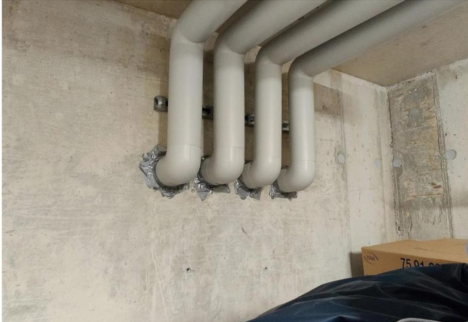
Si un mur d'installation constitue le niveau d'étanchéité à l'air, ce mur devrait être rendu étanche à l'air sur toute sa surface, par exemple par un crépi intégral et des raccords élastiques entre les éléments de construction. Les passages de câbles peuvent également être étanchéifiés à travers l'utilisation de manchettes EPDM préfabriquées.
