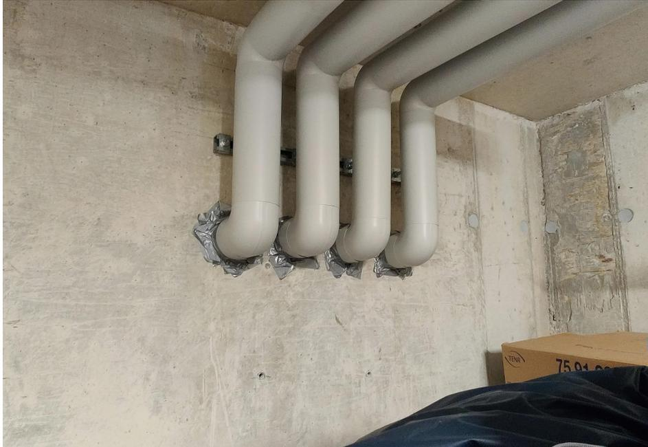
Bildet eine Installationswand die Luftdichtheitsebene sollte diese Wand in der Fläche beispielsweise durch vollflächigen Verputz und elastische Bauteilanschlüsse luftdicht gemacht werden. Die Leitungsdurchdringungen können auch mit vorgefertigten EPDM-Manschetten abgedichtet werden.
