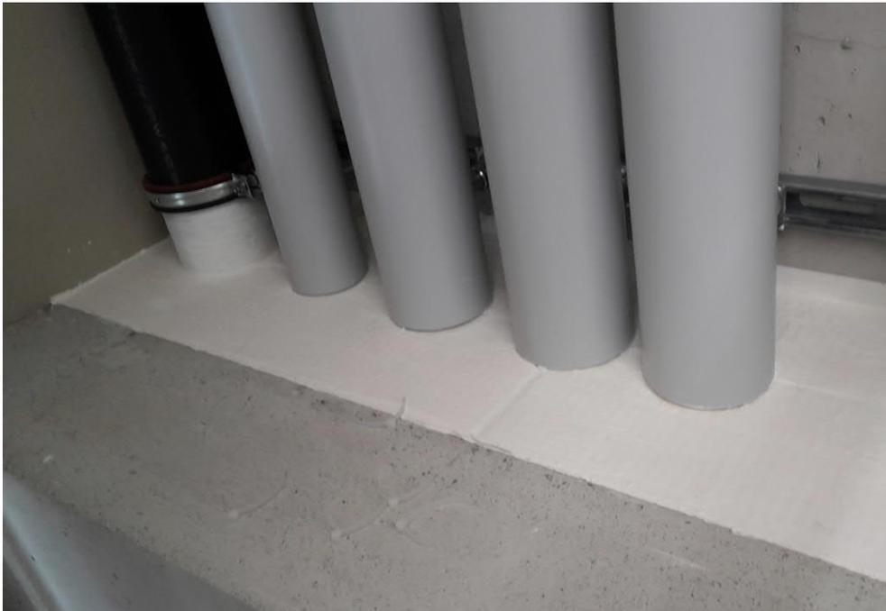
Leitungspakete können, aufgrund der Hohlräume nicht als ein Bündel abgedichtet werden. Jede Leitung muss einzeln abgedichtet werden. Als bessere Lösung gibt es dafür auch vorkonfektionierte Produkte.
