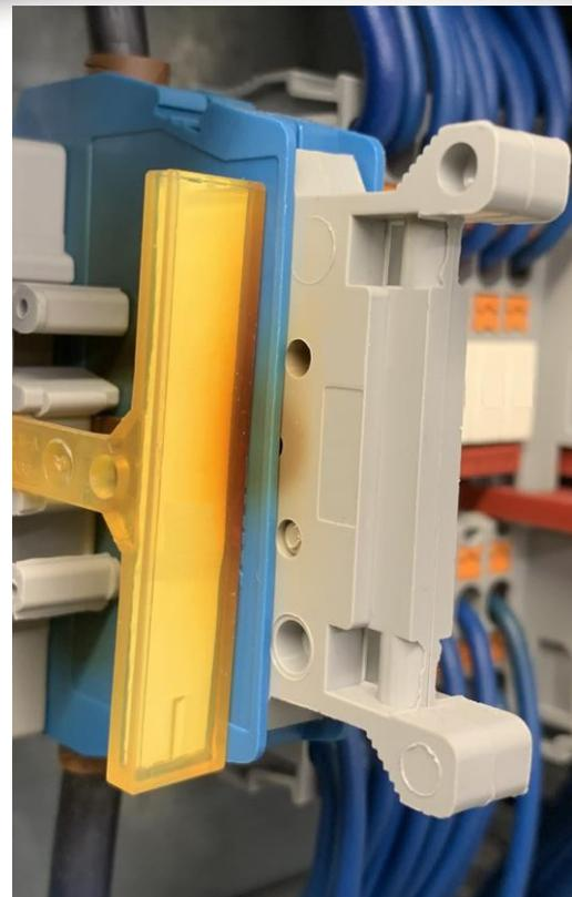
Das IR-Bild zeigt eine Sicherungstrennklemme mit eingesetztem Trennstecker.
